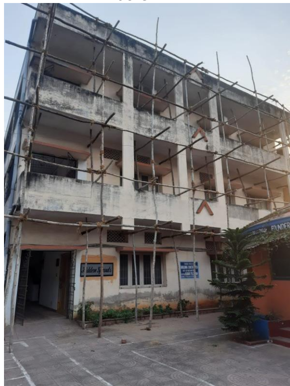
Rénovation des façades avec le soutien de GILDA
